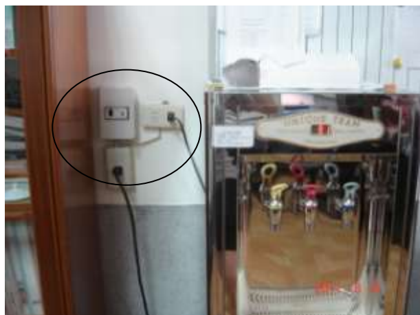
飲水機漏斷電安裝完成
