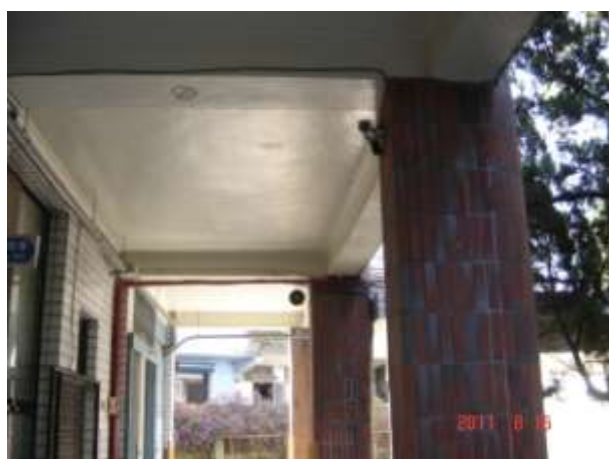
監視器安裝完成(四)
