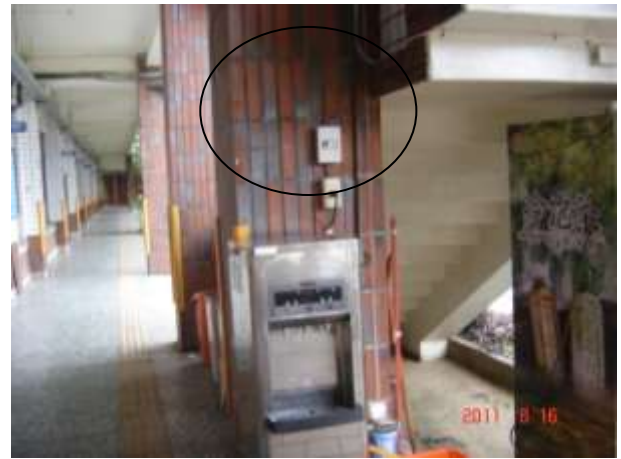
飲水機漏斷電安裝完成
