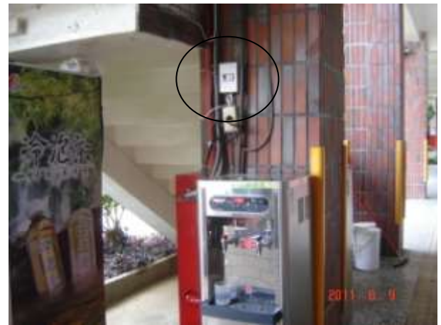
飲水機漏斷電安裝完成
