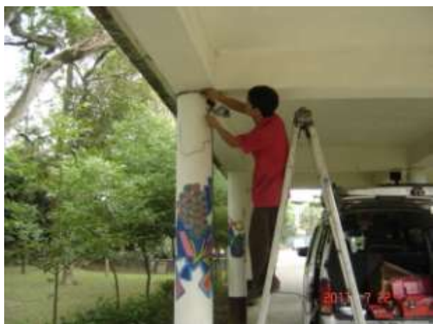
監視器安裝(二)
