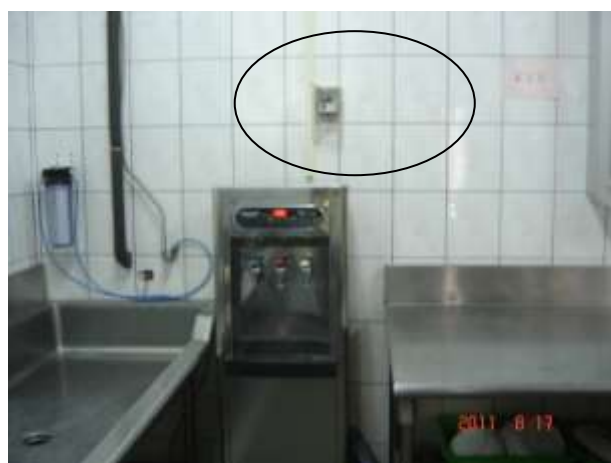
飲水機漏斷電安裝完成
