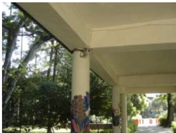
監視器安裝完成(二)
