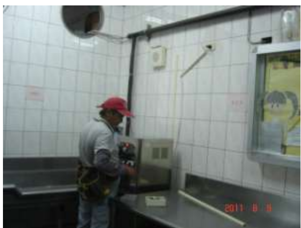
飲水機漏斷電安裝前
