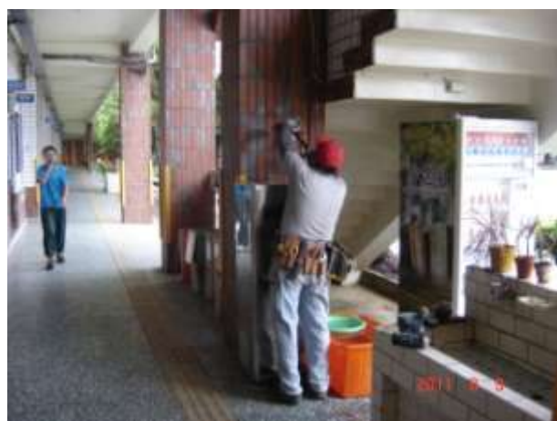
飲水機漏斷電施作
