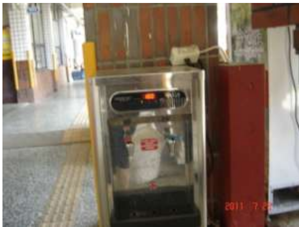
飲水機漏斷電安裝前
