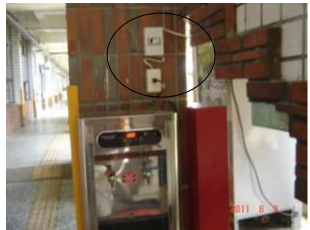
飲水機漏斷電安裝完成
