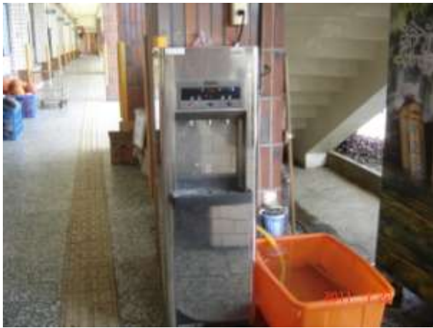
飲水機漏斷電安裝前
