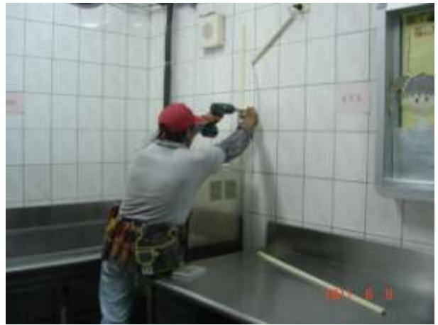
飲水機漏斷電施作
