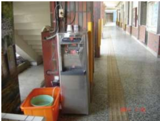
飲水機漏斷電安裝前
