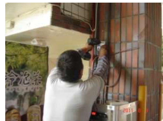
飲水機漏斷電施作
