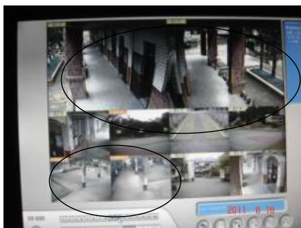
監視器安裝完成(四)
