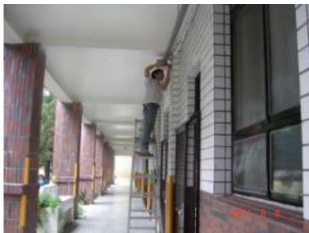
監視器安裝(三)
