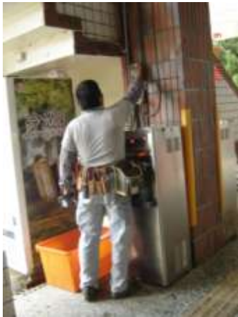
飲水機漏斷電施作
