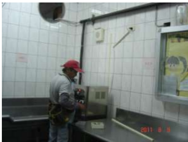
飲水機漏斷電安裝前
