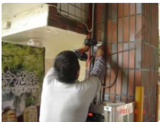
飲水機漏斷電施作
