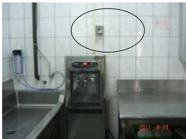
飲水機漏斷電安裝完成
