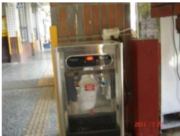
飲水機漏斷電安裝前
