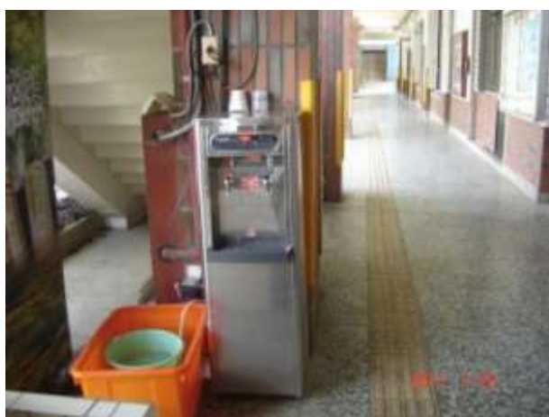
飲水機漏斷電安裝前
