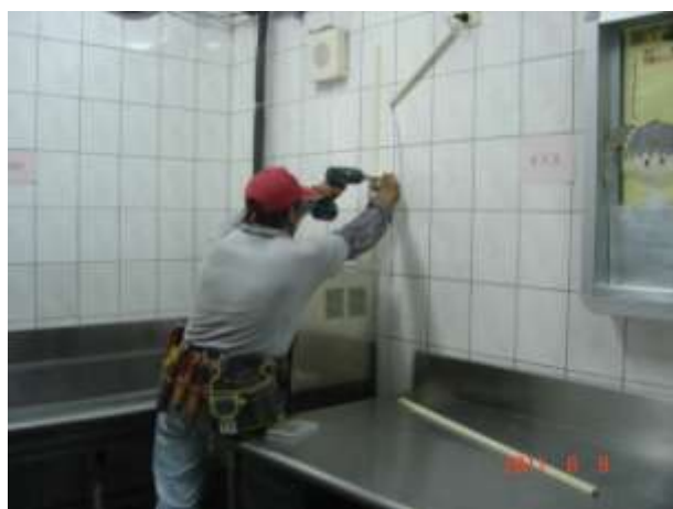
飲水機漏斷電施作
