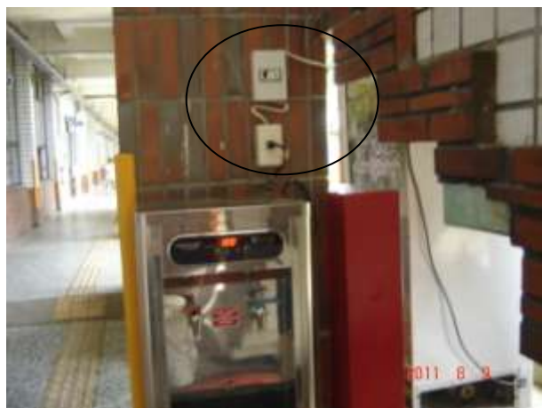
飲水機漏斷電安裝完成
