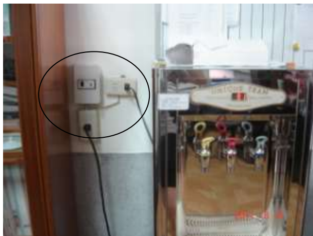
飲水機漏斷電安裝完成
