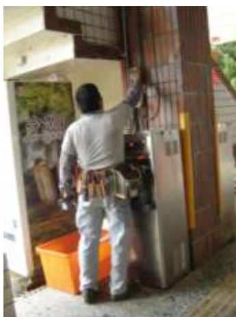
飲水機漏斷電施作
