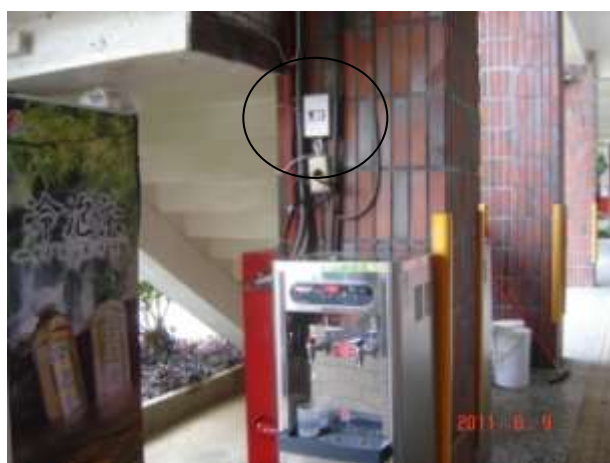
飲水機漏斷電安裝完成
