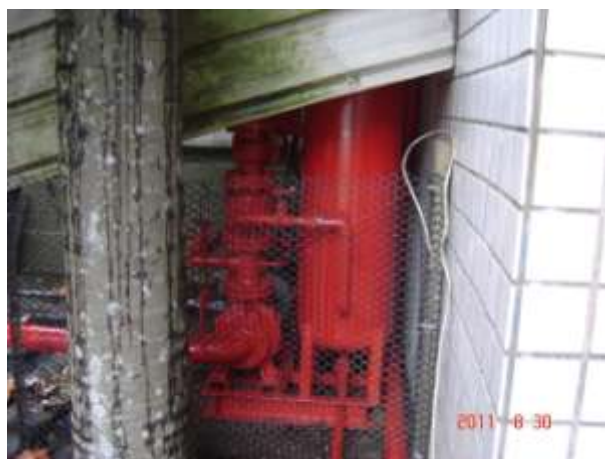
消防管路除銹油漆(改善後)
