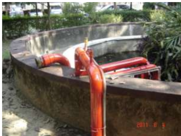
消防管路除銹油漆(改善後)
