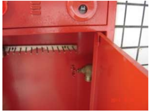
消防栓箱除銹油漆(改善後)
