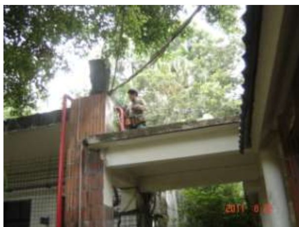
消防管路除銹油漆(改善後)
