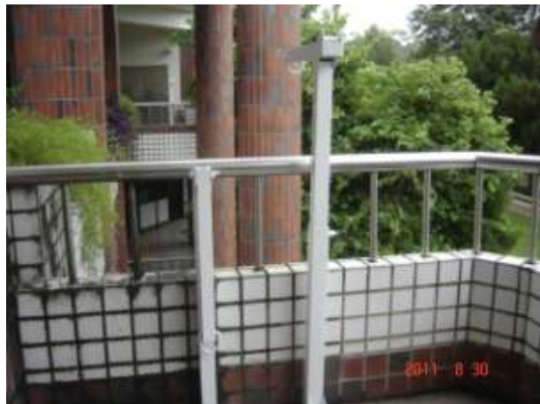
漆緩降機支架油漆(改善後)
