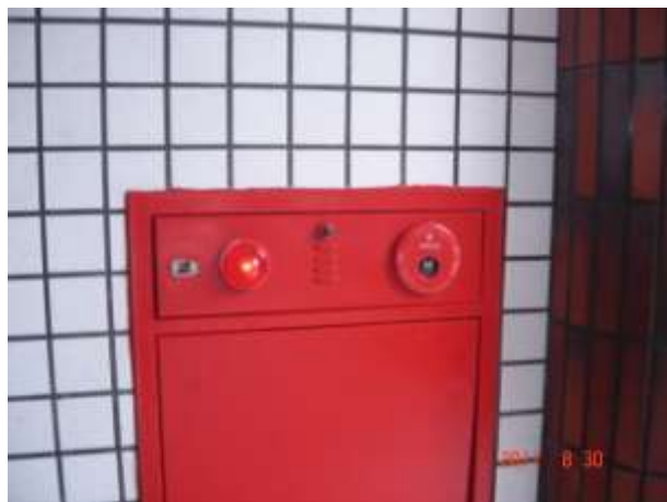
探測器修復(測試)
