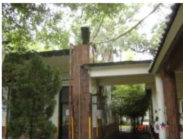
消防管路除銹油漆(改善前)
