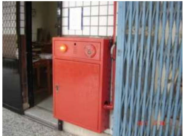
消防栓箱除銹油漆(改善後)
