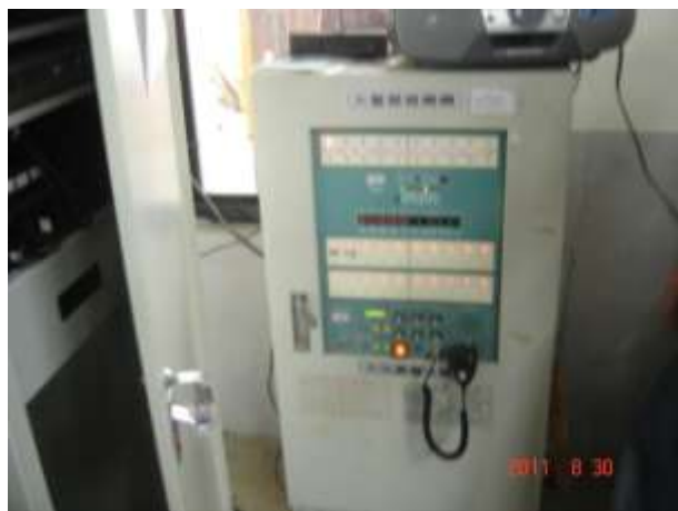
廣播主機電池及線路查修(改善後)
