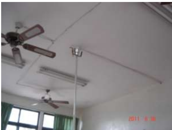
探測器修復(測試)
