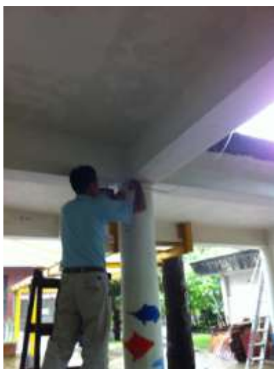
施工安裝情形
