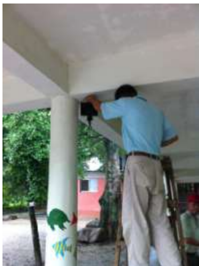
施工安裝情形
