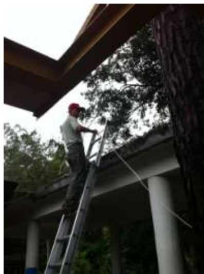
施工安裝情形
