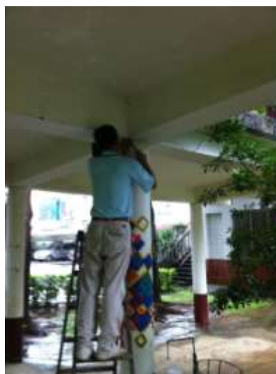
施工安裝情形
