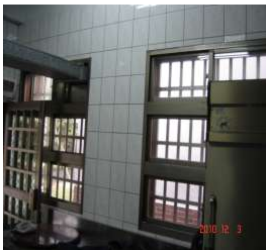
安裝抽風設備前(改善前)
