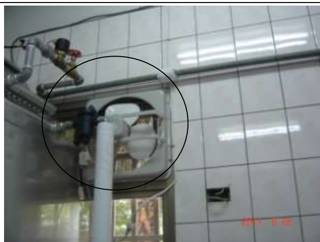
安裝抽風設備 (改善後)
