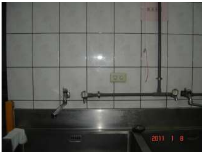
廚房加裝洗手設備前(改善前)
