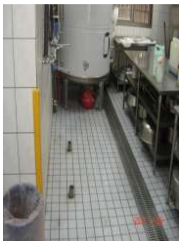
鋪設防滑地板前(改善前)
