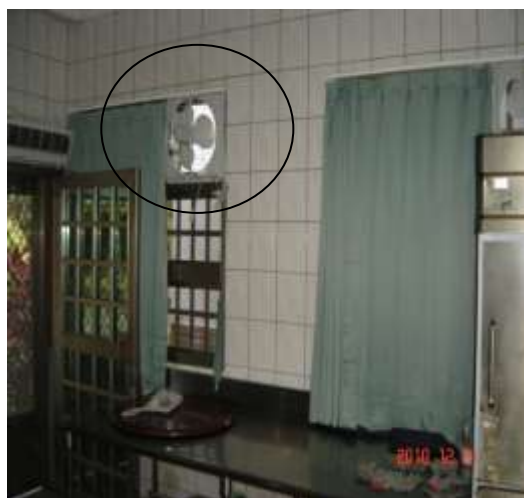
安裝抽風設備 (改善後)
