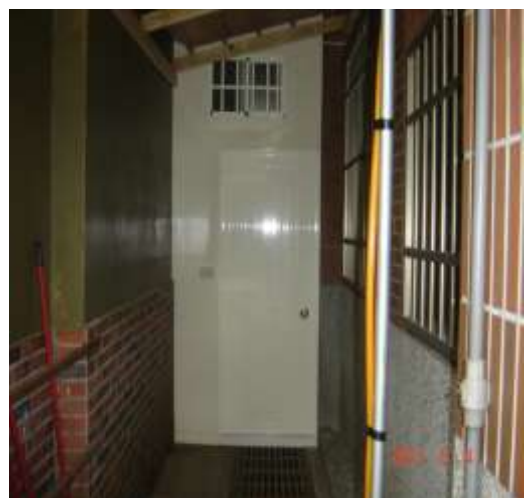
增設廚工更衣室 (改善後)
