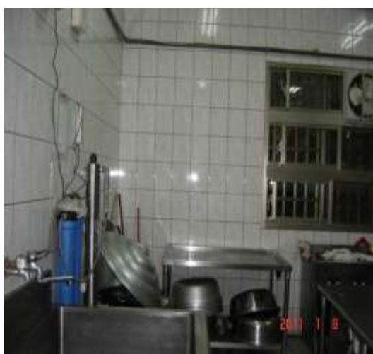
安裝熱泵熱水器前(改善前)
