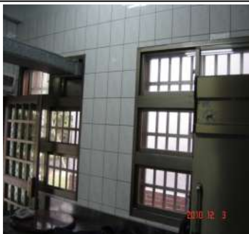
安裝抽風設備前(改善前)
