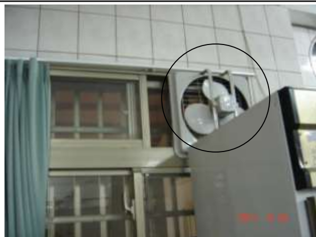
安裝抽風設備 (改善後)
