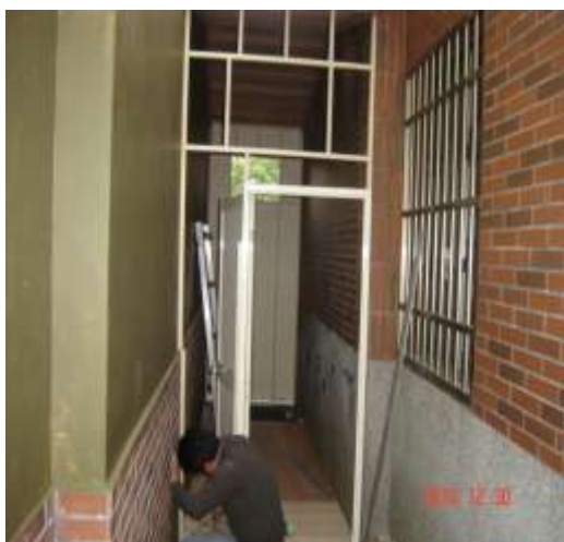
增設廚工更衣室(改善前)
