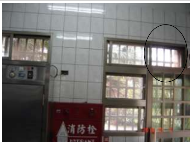
安裝抽風設備前(改善前)
