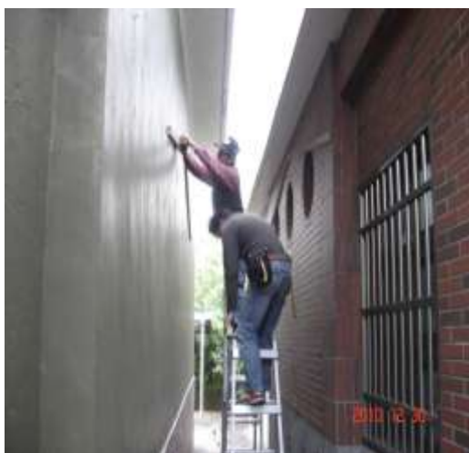
增設廚工更衣室(改善前)
