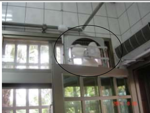
安裝抽風設備 (改善後)
