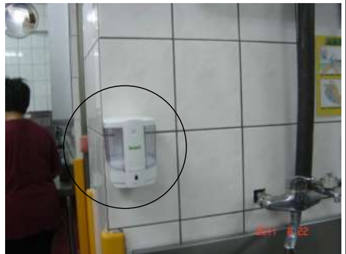
廚房安裝洗手設備-自動給皂液(改善後)
