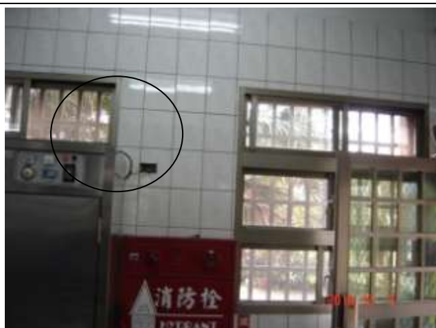
安裝抽風設備前(改善前)
