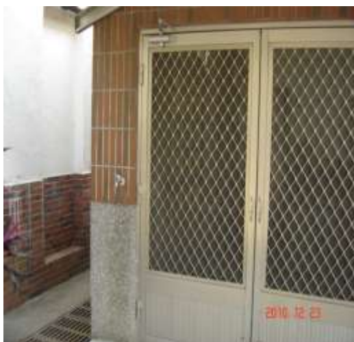
廚房門口加裝洗手設備前(改善前)
